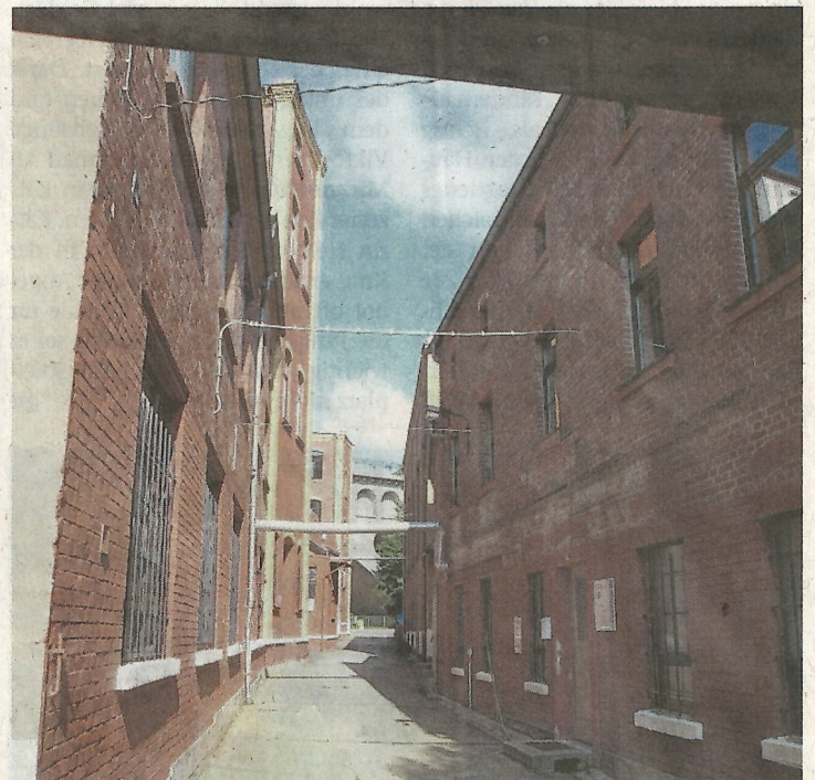
Rechterhand entsteht der Neubau der Schweißerei nach Teilabriss der Turnhalle.
